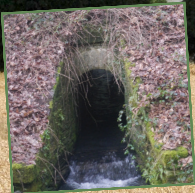
Pont des Arches sur l'ancienne route départementale de Ploërmel
