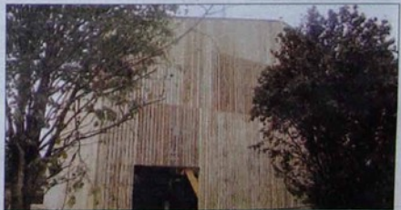
La chaufferie bois alimentera les serres.
