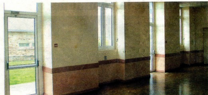
La démolition de cinq piliers constitue l'opération la plus délicate de ce chantier.
